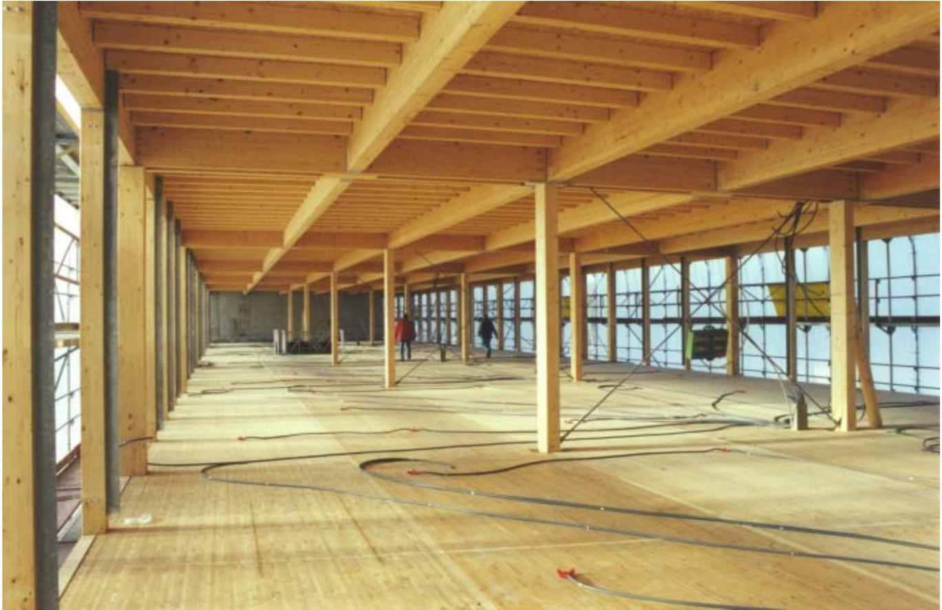
et des locaux de sous-sol en béton armé, une ossature métallique et une structure porteuse bois-métal.
