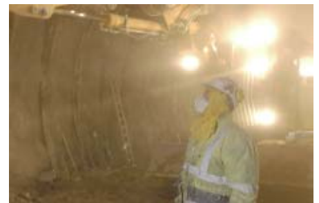
Conditions au front du tunnel
