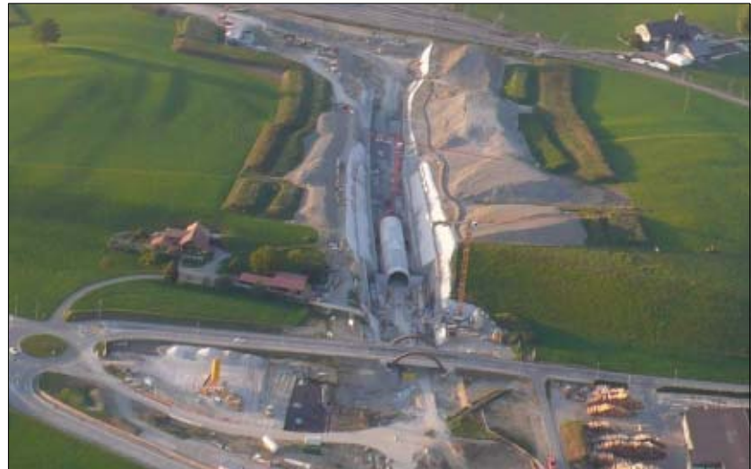
Fig. 1 / Etat des travaux au 16 septembre 2007
