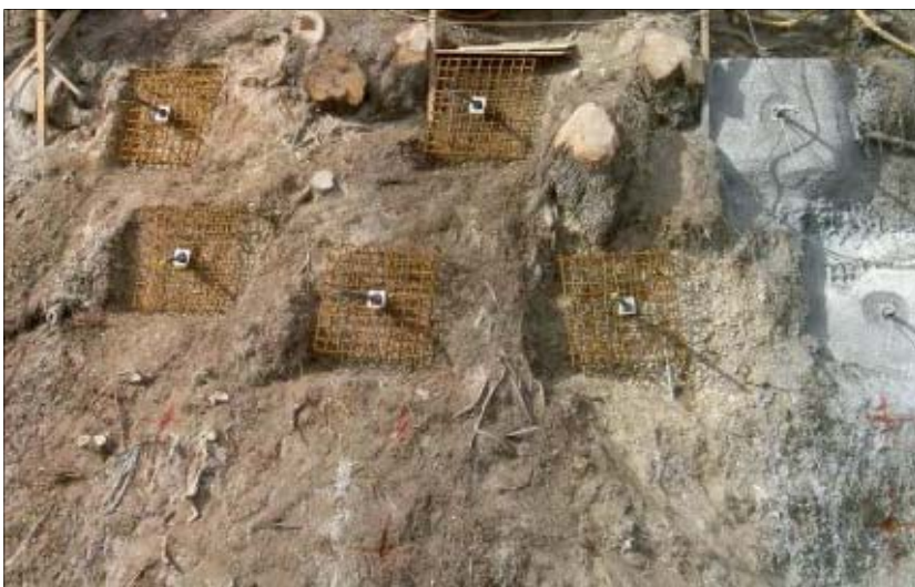
Ancrages actifs avec plaques de tête bétonnées
