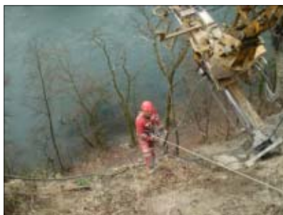
Forage avec affût monté sur pelle mécanique
