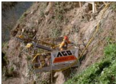
Forage avec affût mobile sur nacelle
