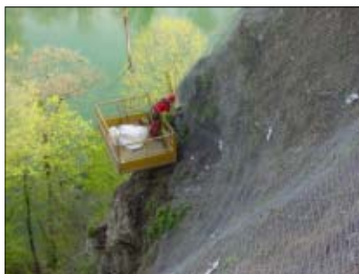
Fixation du treillis de protection
