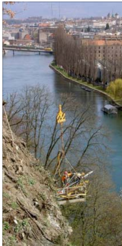
Forage avec affût monté sur pelle mécanique
