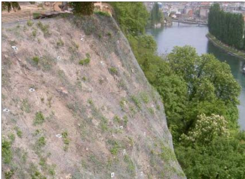
Travaux d'assainissement de la falaise terminés
