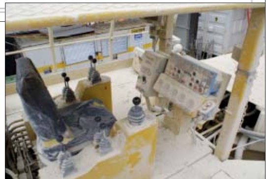
Poste de pilotage de la haveuse: un écran permet au pilote de visionner la section d'excavation théorique en rapport avec l'emplacement précis de la tête de la haveuse, la position de celle-ci étant localisée par laser.
