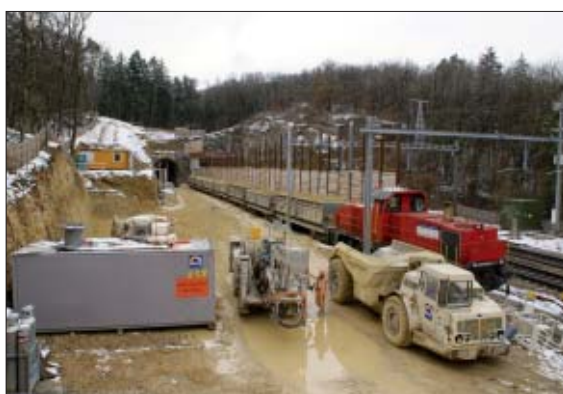
Place principale de chantier côté Bavois avec train d'évacuation des matériaux. Dès la mise à l'enquête, il a été convenu avec Holcim d'évacuer ce calcaire en le recyclant dans les fours à ciment de l'entreprise.
