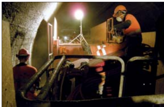
Les CFF ont dû prendre des mesures préalables de confortation des anciens ouvrages dans toutes les zones où les tunnels sont très rapprochés, ainsi que les zones où il y a de la moraine. Ces travaux de nuit, qui consistaient à injecter du coulis de ciment derrière la maçonnerie, ont duré 6 mois et été achevés à mi-décembre 2008.
