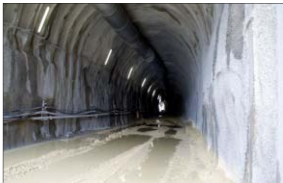
Situé dans le calcaire, le percement du tunnel nord, qui a débuté en septembre 2008 au moyen d'une haveuse, est aujourd'hui terminé.
