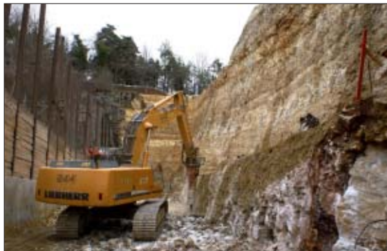
Excavation finale de la falaise. Depuis le portail sud et sur les 40 premiers mètres, le nouveau tunnel ne sera distant que de 3 à 4 mètres du tunnel existant.
