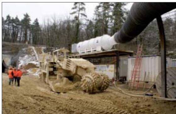
Haveuse à ciel ouvert devant le portail sud du tunnel nord.
