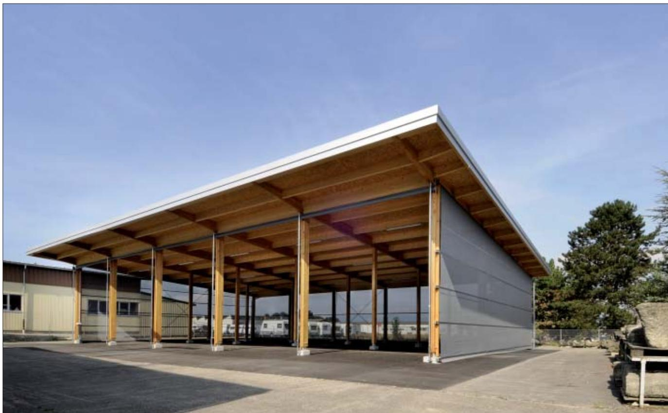
Des enrouleurs électriques actionnent les filets de chacune des deux façades principales sur une longueur de 26 m et une hauteur de 6 m.
