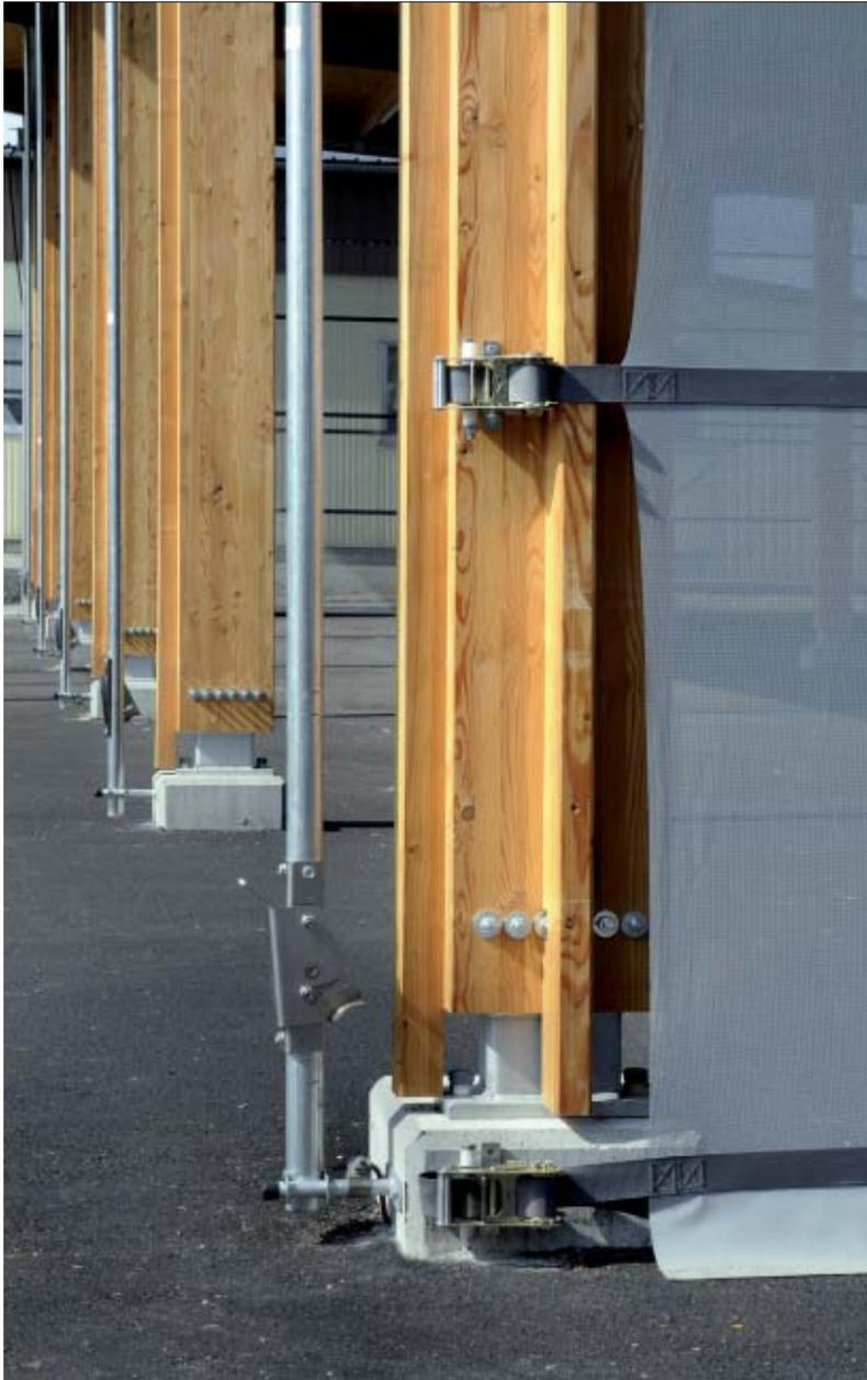
Devant chaque poutre, un tube évite le contrebalancement du rideau et permet de garder celui-ci en tension. Au bas de chaque tube, un mécanisme manuel garantit un blocage du filet.
