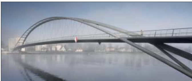
Grâce à la finesse de sa structure, l'élégance et la force de son dessin, la passerelle des Trois Pays s'impose comme un lien tangible entre les trois communes: Huningue en France, Weil-am-Rhein en Allemagne, et Bâle en Suisse. Photo: David Boureau
