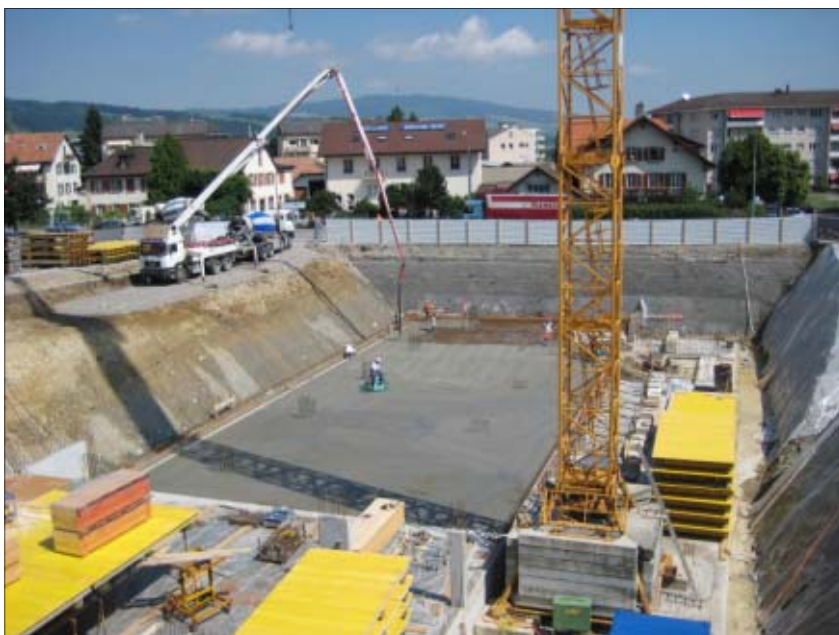
Bétonnage de la dalle de fond du parking
