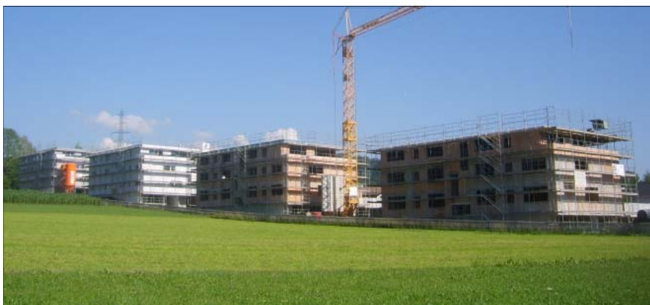
Quatre des cinq immeubles en construction
