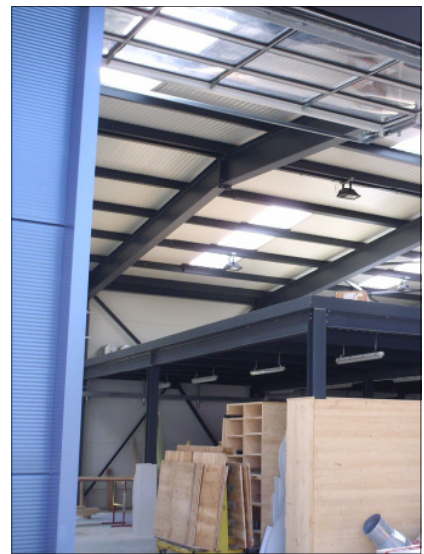
Halle de stockage et ateliers
