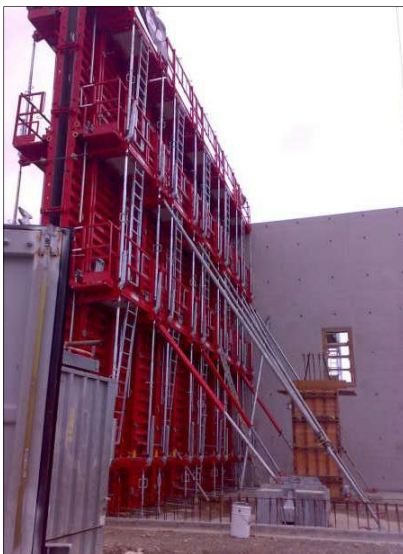
Coffrage pour murs biais
