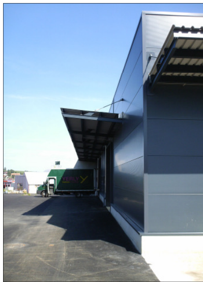
Auvent sur façade Ouest
