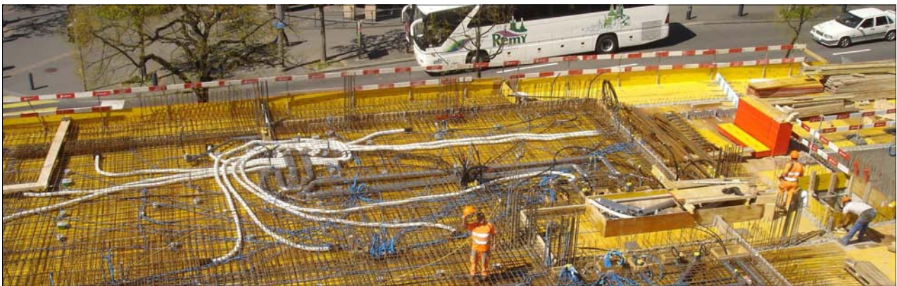
Ci - dessus : coffrage et armature de la dalle niveau +5 mis en place
