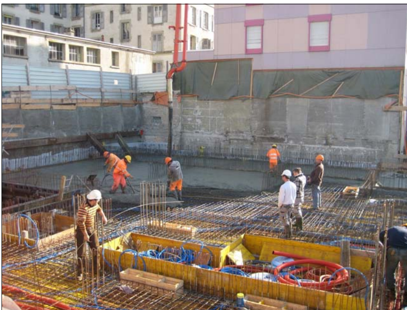
Bétonnage d'une dalle d'un des niveaux en sous-sol
