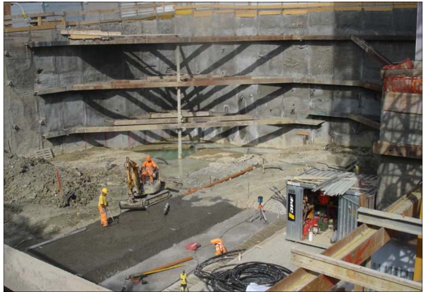
Terrassement terminé, mise en place des canalisations et du béton caverneux
