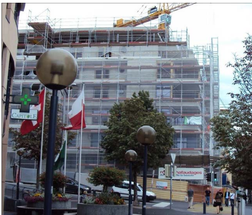
Travaux de gros œuvre réalisés sur tous les étages, échafaudages mis en place
