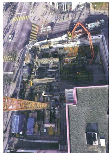
Ci - dessus : coffrage et armature de la dalle niveau +5 mis en place
