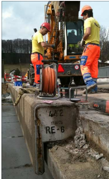
Démolition de bordure d'un passage supérieur
