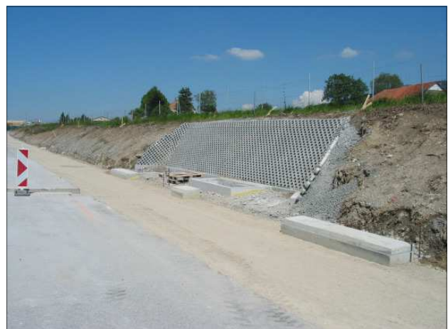
Construction d'une niche SOS avec chambre de tirage EMS
