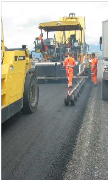
Pose de revêtement bitumineux
