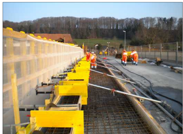
Coffrage et ferrailage de nouvelles bordures d'un passage supérieur
