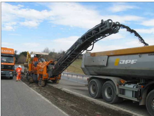
Fraisage du revêtement existant
