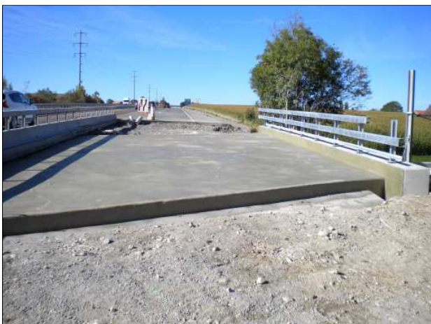
Surfaces de béton assainies prêtes pour la pose de l'étanchéité (PI)
