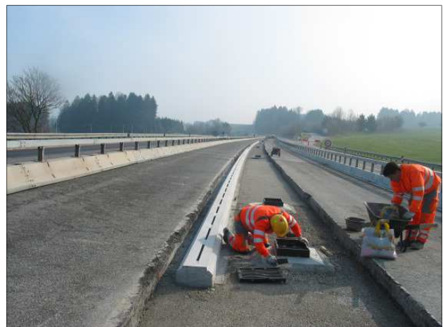
Caniveau fendu mis en place et pose des cadres pour grille
