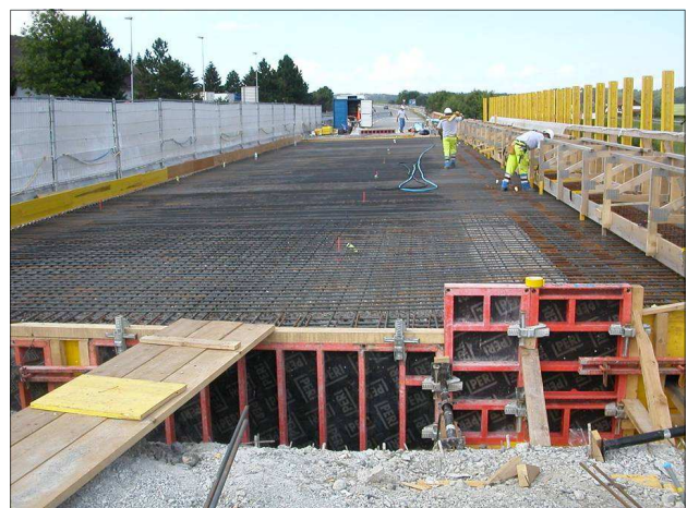
Coffrage et ferrailage pour le nouveau béton de la dalle de pont
