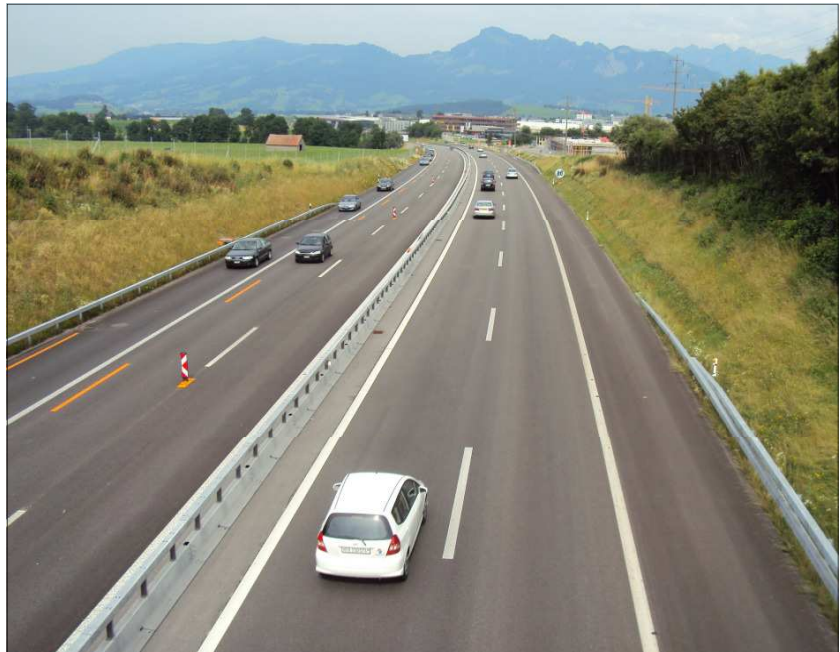
Travaux d'assainissement terminés (tronçon près de la sortie Bulle - Riaz)
