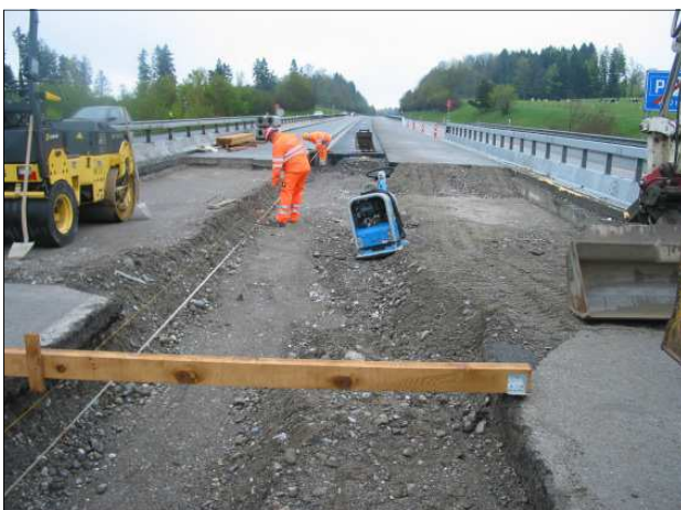
Remblayage sur un passage inférieur assaini
