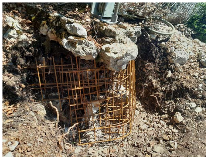
Réfection des socles existants de pare-pierres
