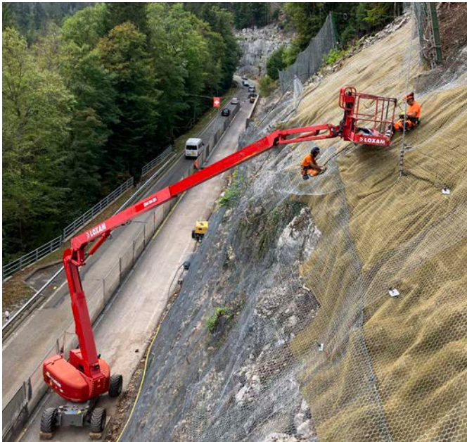
Mise en place natte contre érosion
